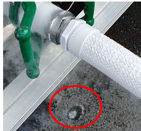
Abbildung 24: Leckage an der Kupplung bei der Wiederbefüllung der Tankstelle auf der Tankstellenseite
