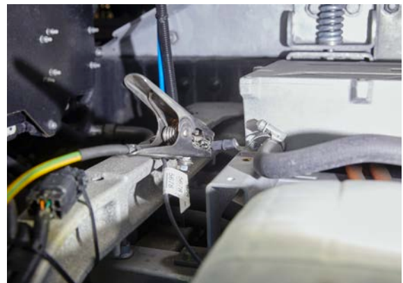
Ein geeigneter Potenzialausgleich verhindert elektrostatische Entladungen.
