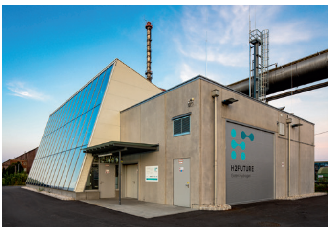
La plus grande centrale pilote de production d'hydrogène sans rejets de CO 2 au monde est implantée à Linz. (Photo: Voestalpine)
