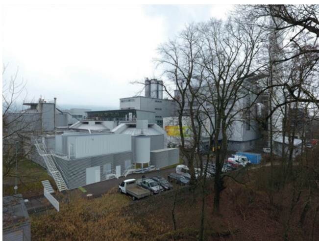
Auf dem Areal der Limeco in Dietikon wird schweizweit die erste industrielle Power-to-Gas-Anlage realisiert. (Foto: Limeco)
