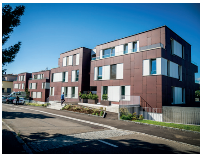
Die beiden Mehrfamilienhäuser in Männedorf bieten Platz für 16 Familien. Mit Photovoltaikmodulen an Fassaden und Dächern sowie zwei Windrädern wird erneuerbarer Strom lokal produziert. (Foto: Umwelt-Arena)
