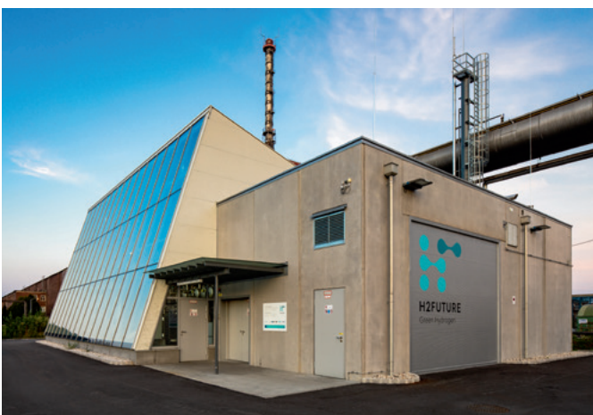
In Linz steht die weltweit grösste Pilotanlage der Welt, um grünen Wasserstoff herzustellen. (Foto: Voestalpine)
