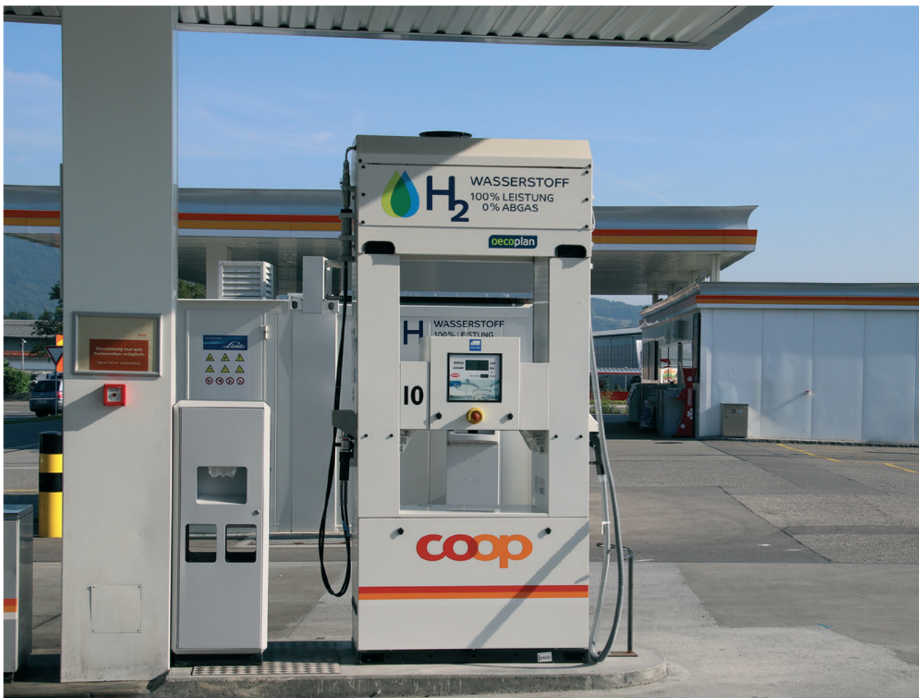
Die erste öffentliche Wasserstofftankstelle der Schweiz ist seit 2016 in Hunzenschwil (AG) in Betrieb.
